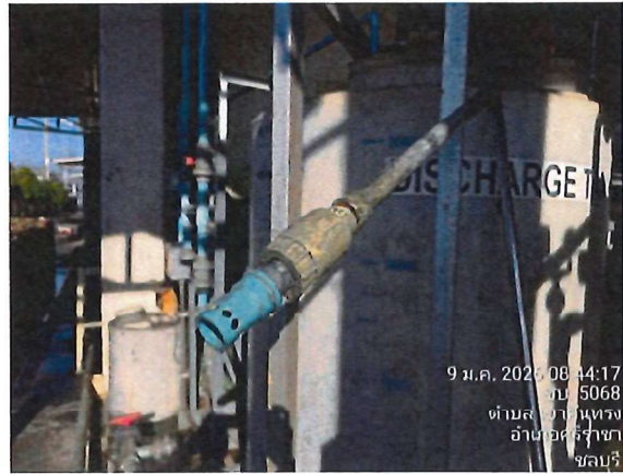
ภาพที่ 15 เครื่องตรวจวัด pH แบบอัตโนมัติ
